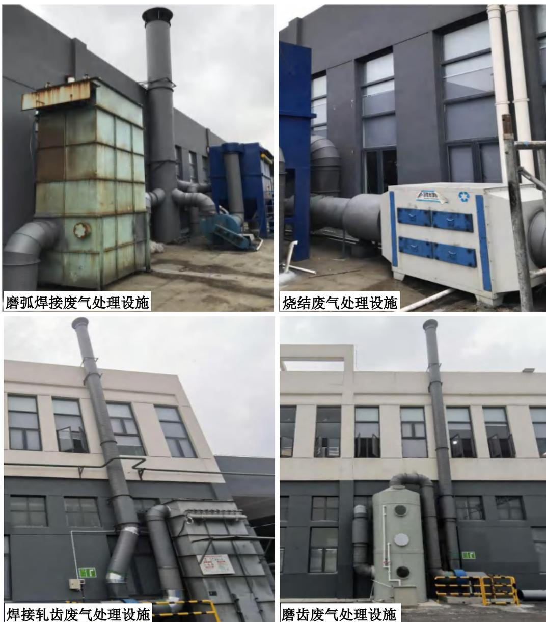
图 4-4 各工序废气污染防治设施现场图
